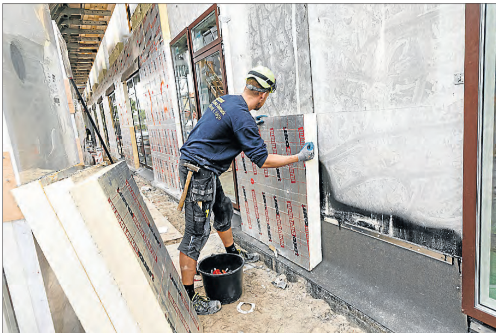
En tømrermester kunne gå knapt 25 cm ned i vægtykkelse ved at bruge skumisulering. Det betyder, at han får en lysning på 40 cm og ikke 60+ cm. (Foto: John Ehbrecht)
