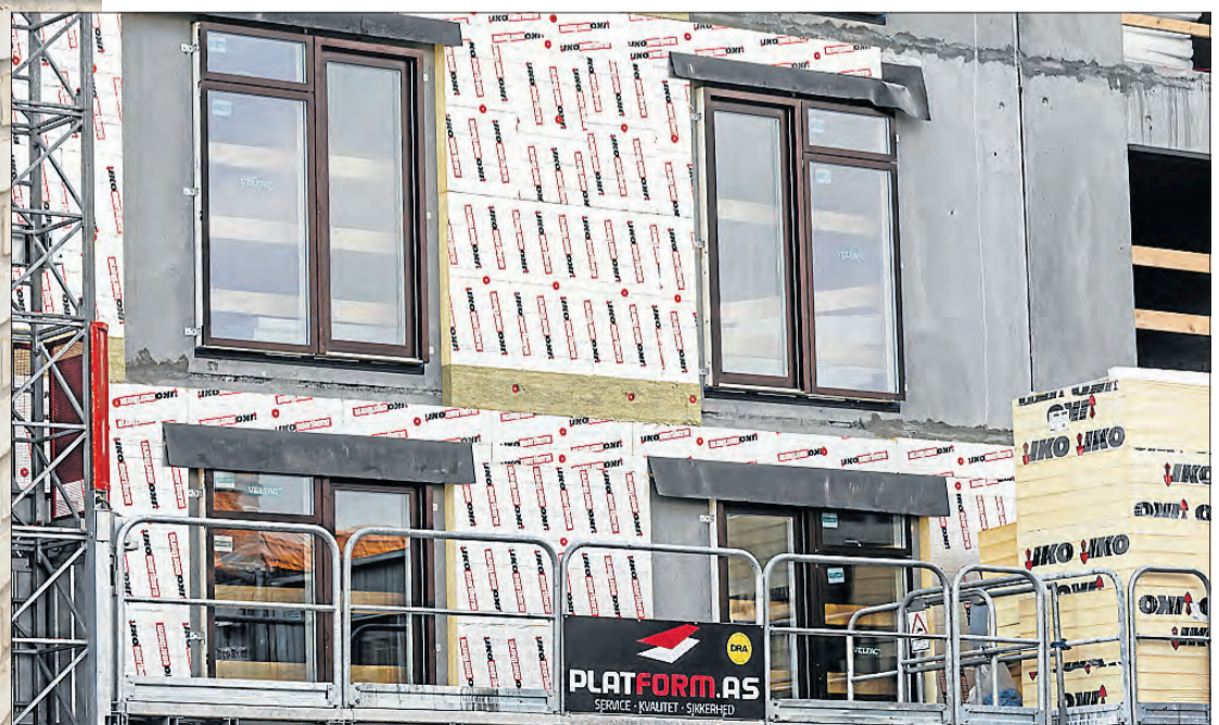
Skumisulering kan generelt anvendes på steder, hvor der ellers anvendes mineraluld. (Foto: John Ehbrecht)
