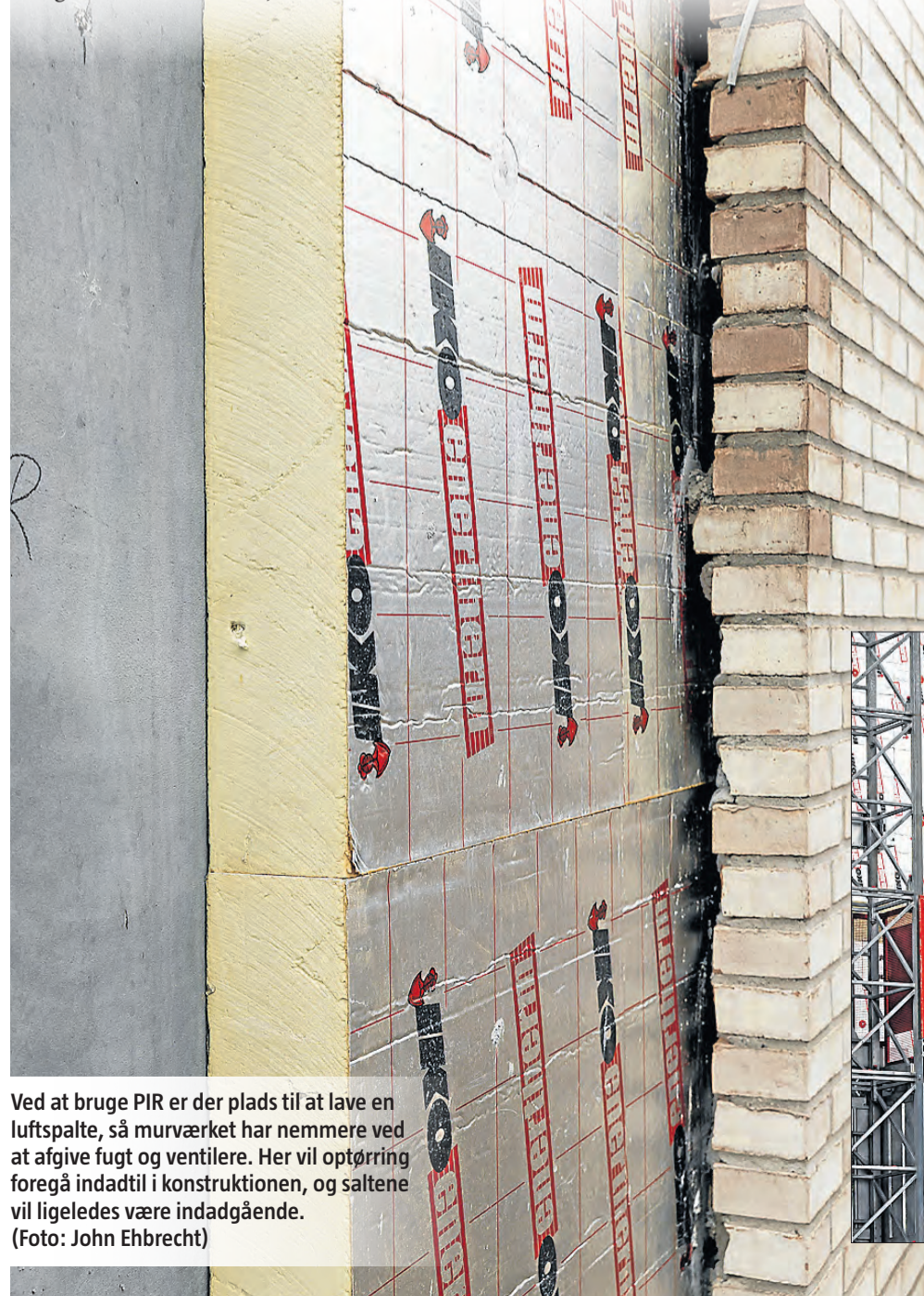
Skumisulering kan generelt anvendes på steder, hvor der ellers anvendes mineraluld. (Foto: John Ehbrecht)
